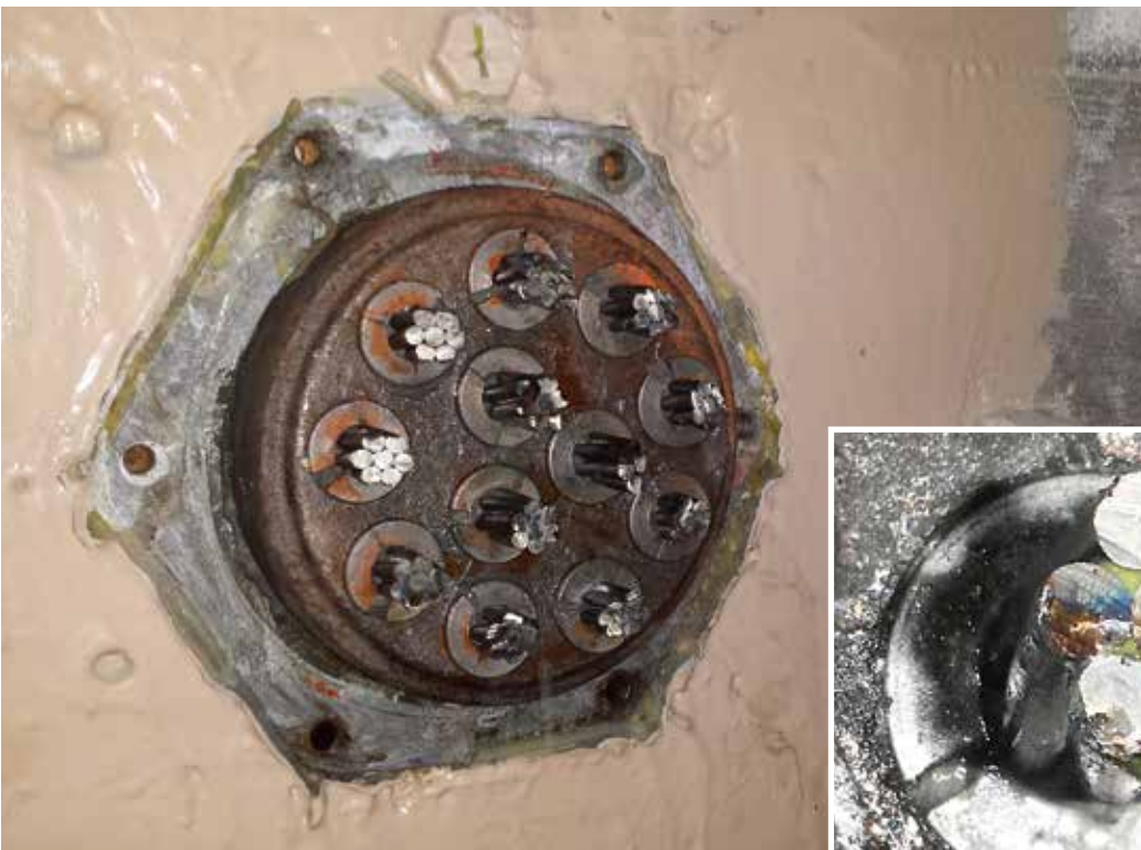
주입 완료 후 텐던의 단부에서 주입된 Post-Tech PTI Impregnation 재료(그림에서 황색 액상 물질)가 75m 길이 강연선의 반대쪽으로 배출된 모습
