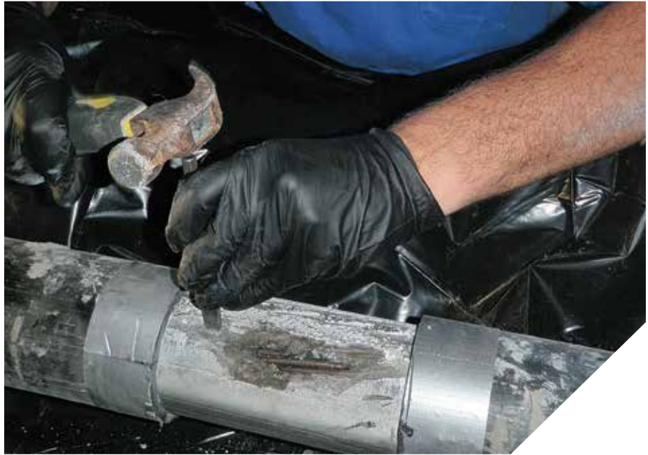
Post-Tech PTI 시공 완료 후 강연선 주변 그라우트에 함침된 상태를 육안으로 확인하기 위한 텐던 검사
